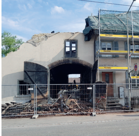
Un incendio ha distrutto quasi completamente l'appartamento.
